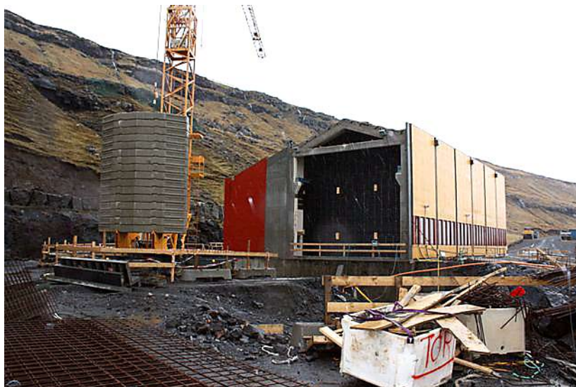
Eiðisverkið verður í lötuni útbyggt at hýsa triðju turbinuni.
