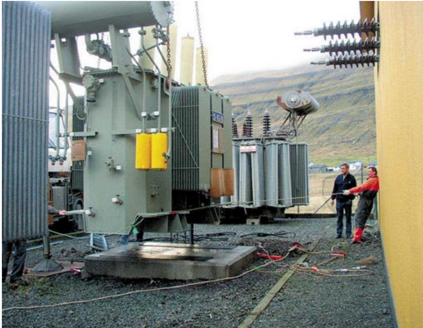
30 tons verða lyft yvir á ein betongfót. Nýggi transformarin, sum varð settur upp á koplingsstöðini hjá SEV í Skálabotni í november 2004, kom í staðin fyri tann gamla transformaran frá sekstíárunum, tá SEV eisini setti transformarar upp í Havn og Vestmanna. Á myndini Steen Juul Pedersen, kaðal- og linjumeistari í Skálabotni, v.m., og Marni Weihe, linjuformaður í Skálabotni, h.m.
