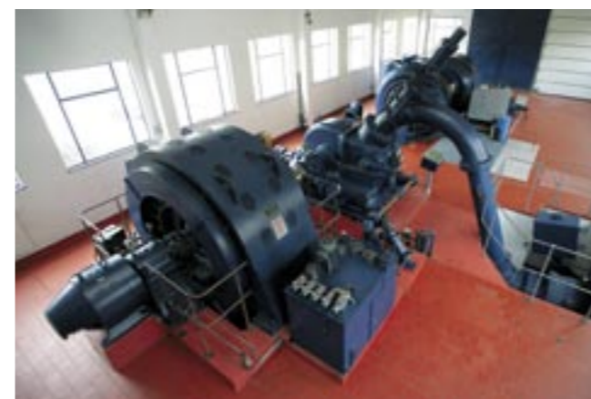
Fossáverkið í Vestmanna samskipar framleiðsluna á meginøkinum. Hadaði fáa hini verkini boð um, nær og hvussu nógv tey skulu framleiða til tess at nøktast streymtørvin. Turbinurnar á verkinum eru frá fimmti-árunum og eru tær fyrstu, SEV fór at framleiða streym við.
