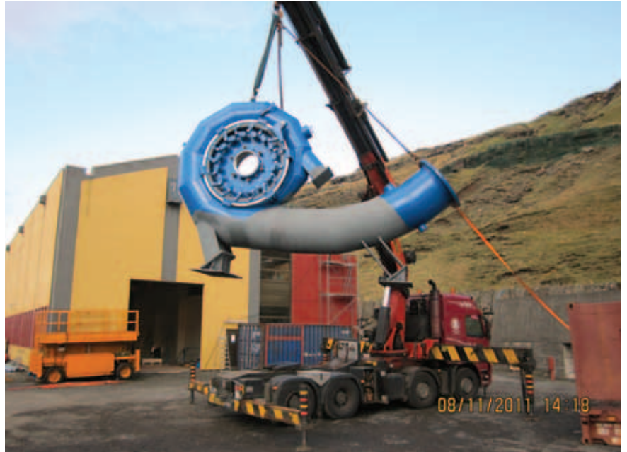
Ventilur og turbina 3 verða heysað upp á pláss
