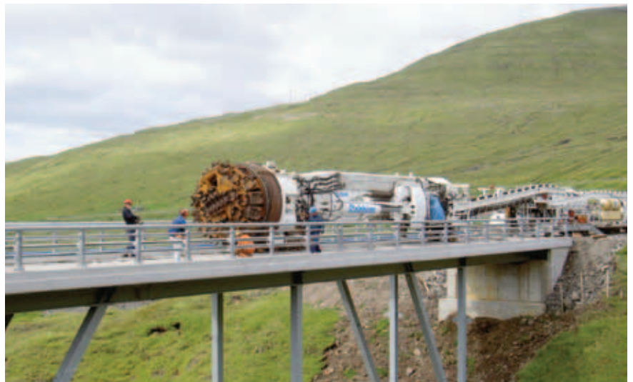
Borimaskinan á veg til arbeiðis
