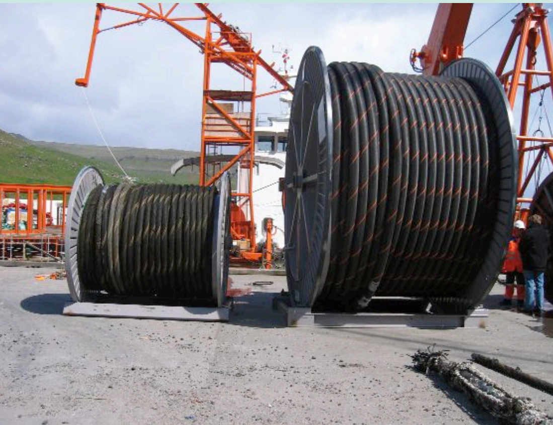
KADALTRUMLUR VID 20 KV OG 60 KV SJÓKADALI
