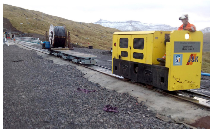
Lokomotivið, ið verður nýtt til flutning inn og út úr tunlinum. / The locomotive that is used for transportation in and out of the tunnel.
