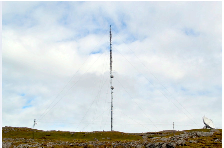
Mastur hjá Føroya Tele á Húsareyni / A Føroya Tele mast at Húsareyn.
