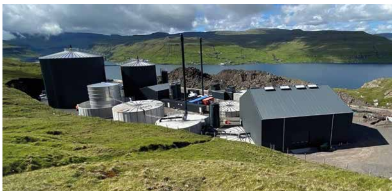
Færka biomass power plant
