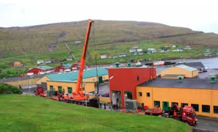
Útskipting av transformarum á Fossáverkinum. / Replacement of transformers at the Fossá power plant.
