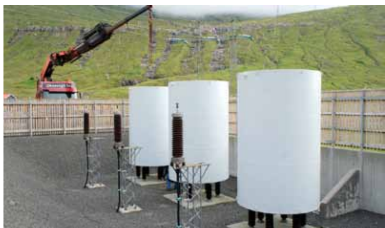
Útskipting av reaktorspolum í Skálafirði. / Replacement of reactor spools at Skálafirði.
