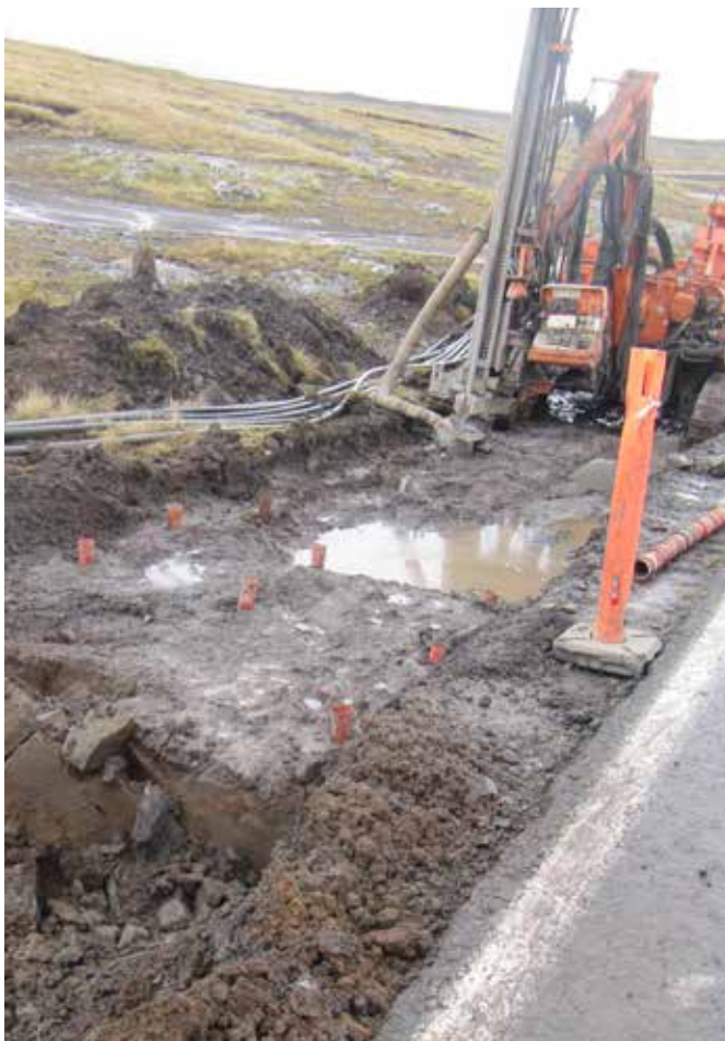
Kaðlarnir skulu liggja minst 70 sentimetrar undir jörð. Stundum er neyðugt at bora og sprengja fyri at fáa kaðlarnar at liggja nóg langt niðri. Cables should be laid at least 70 centimetres underground. Often, it is necessary to blast to ensure that the cables can be laid deep enough.
