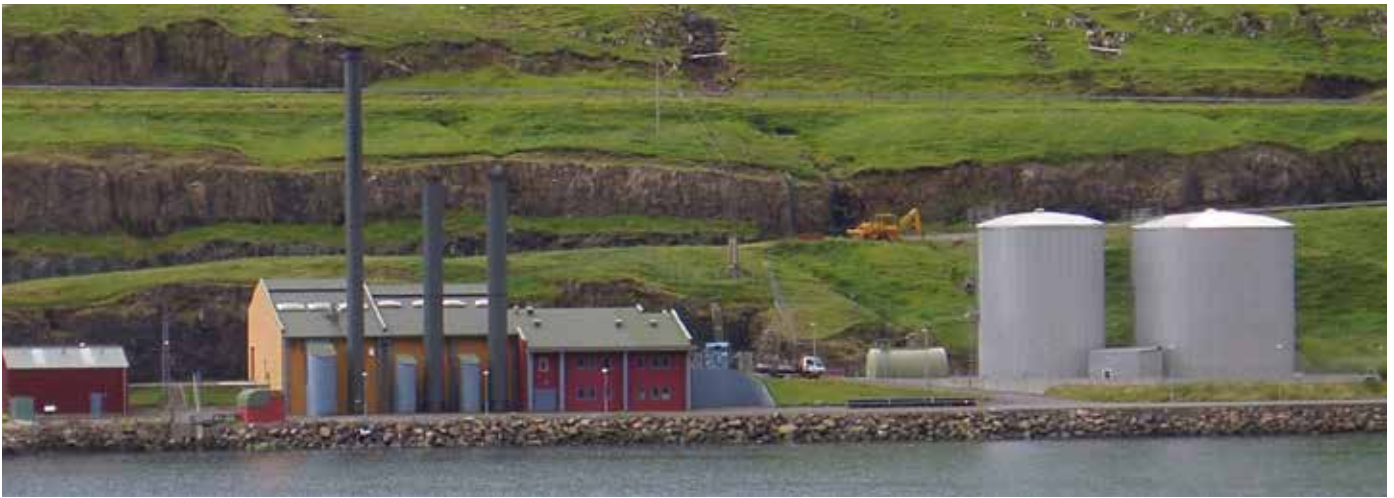
Vágsverkið verður víðkað til at hýsa einum motori afturat. Verkið skal tryggja Suðuroynni nóg mikið av streymi í komandi tíðum. The Vágur power plant will be expanded to house another motor. The power plant will ensure that Suðuroy has enough power to meet increasing demand for the foreseeable future.
