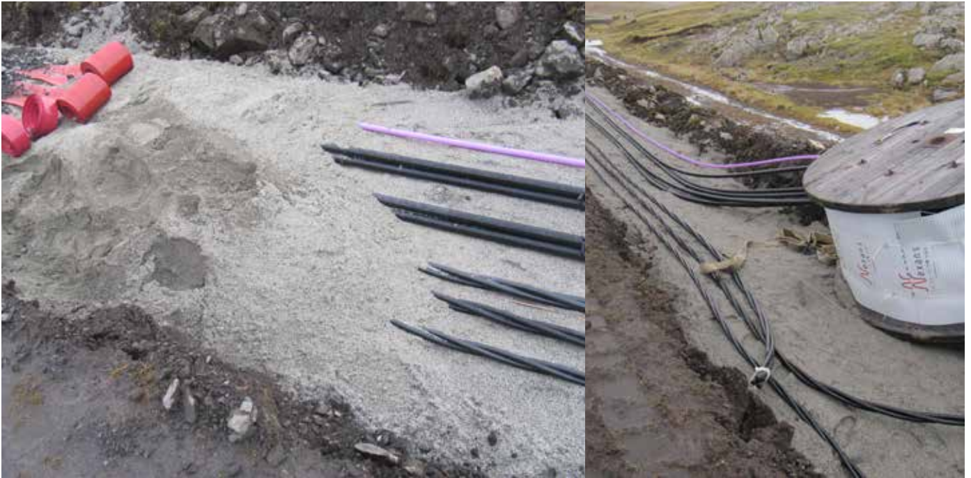
Kaðlamir verða lagdir í sand fyri at tryggja, at teir ikki liggja upp at gróti ella skørpum lutum. Sandurin verjir eisini ímóti, at møguligt skammlop í einum kaðli breiðir seg til hinar kaðlamar. Cables are surrounded by sand to ensure that rocks or other sharp objects do not inadvertently damage the power cables. Sand also protects against possible short-circuits arcing to other cables.
